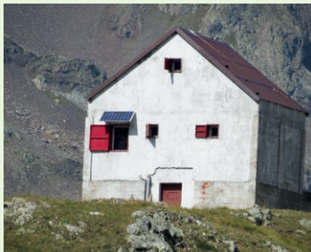
Cabane de berger isolée et maintenant connectée.
