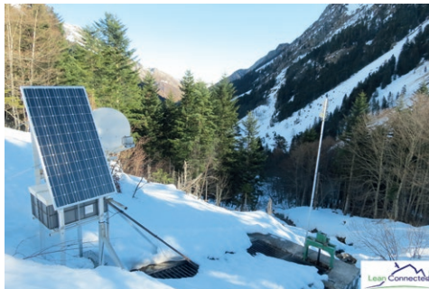
Station de connexions autonomes solaires en territoires isolés.
